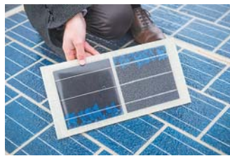
Un hombre muestra una parte de la carretera equipada con paneles solares durante su inauguración. EFE/Archivo
